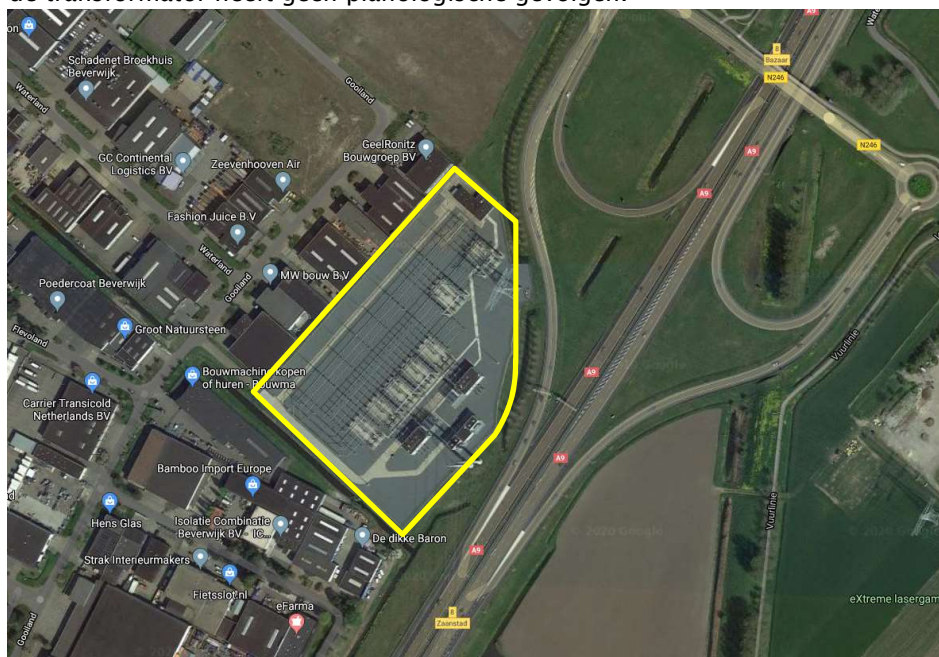
Figuur 2.4: huidig 380kV-station Beverwijk met locatie nieuwe transformator (bron: TenneT / Google Maps)
