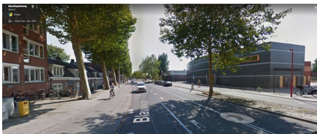
Figuur 2.3: afbeelding van een schakelstation (in GIS-uitvoering) aan de Blauwkapelseweg te Utrecht (bron: TenneT / Google Maps)
